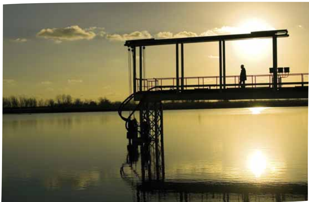
Dankzij de nieuwe compacteringstechnologie kan de gebruiksduur van de goethietbakkens in Balen, België, worden verlengd.
